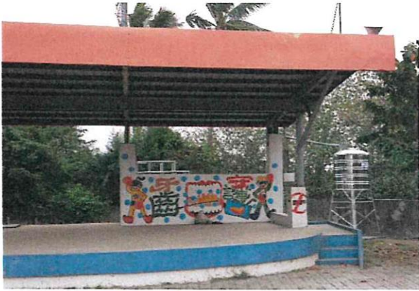
司令台左側申請水撲滿計畫安裝雨水回收裝置
