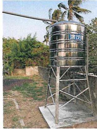
3000 公升水塔收集之雨水可供植物澆灌
